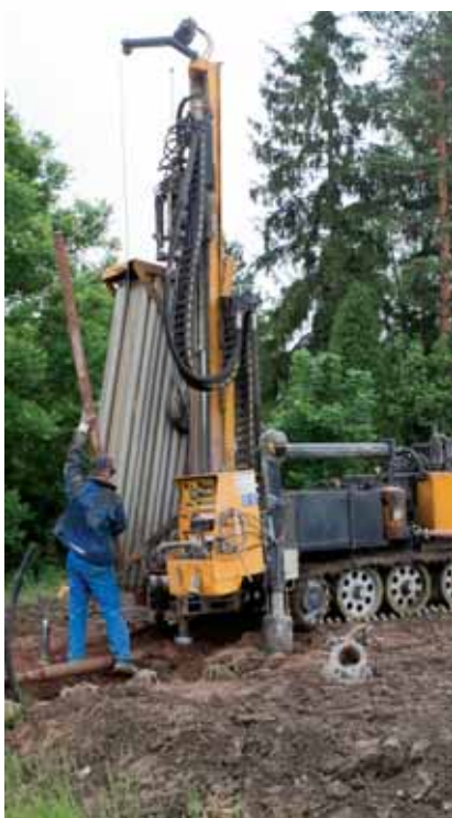
Porakaivo on yleisin maalämpöpumpun lämmönlähde.
