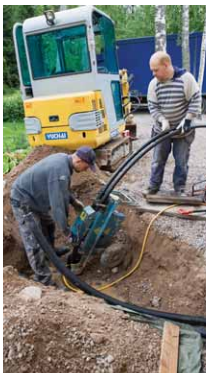
Lämmönkeruuputkisto asennetaan porakaivoon ja täytetään jäätymättömällä keruuliuksella.
